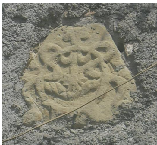
Particolare di fregio in arenaria posto sull'ingresso principale di un edificio tutelato Fonte: rilievo del patrimonio edilizio
