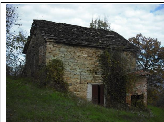
Edificio rurale di base e di interesse situato nel comune di Prignano sulla Secchia
