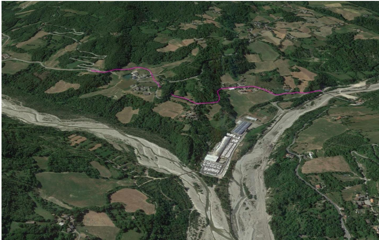
Vista a volo d'uccello dell'infrastruttura, da nord
