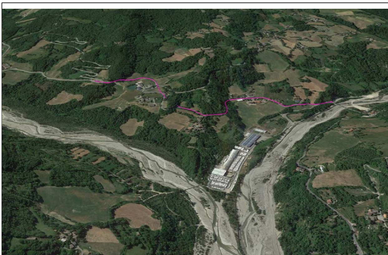
Vista a volo d'uccello dell'infrastruttura, da nord
