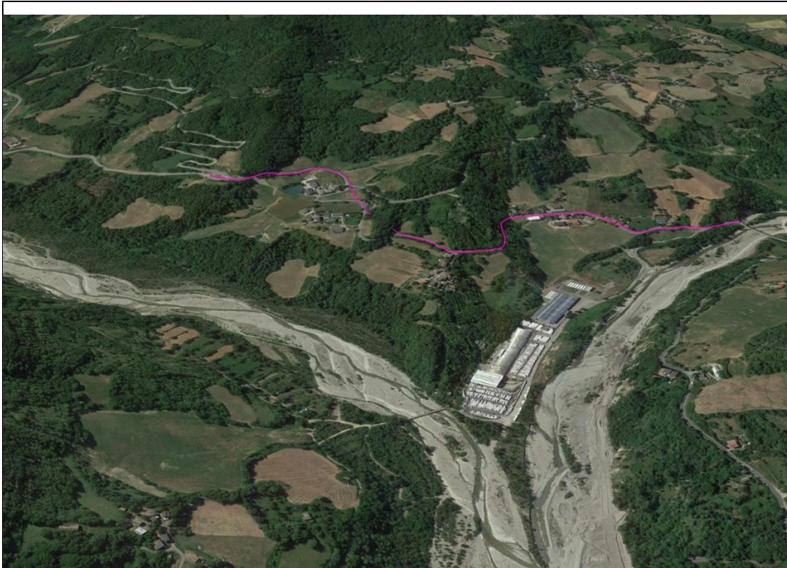
Vista a volo d'uccello dell'infrastruttura, da nord
